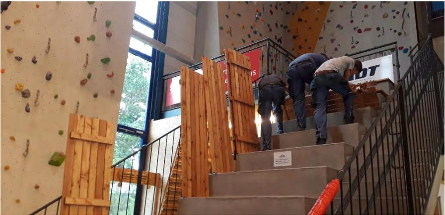
Die Sitzbretter der Tribüne wurden abgebaut, abgeschliffen, neu eingelassen und wieder eingebaut.
