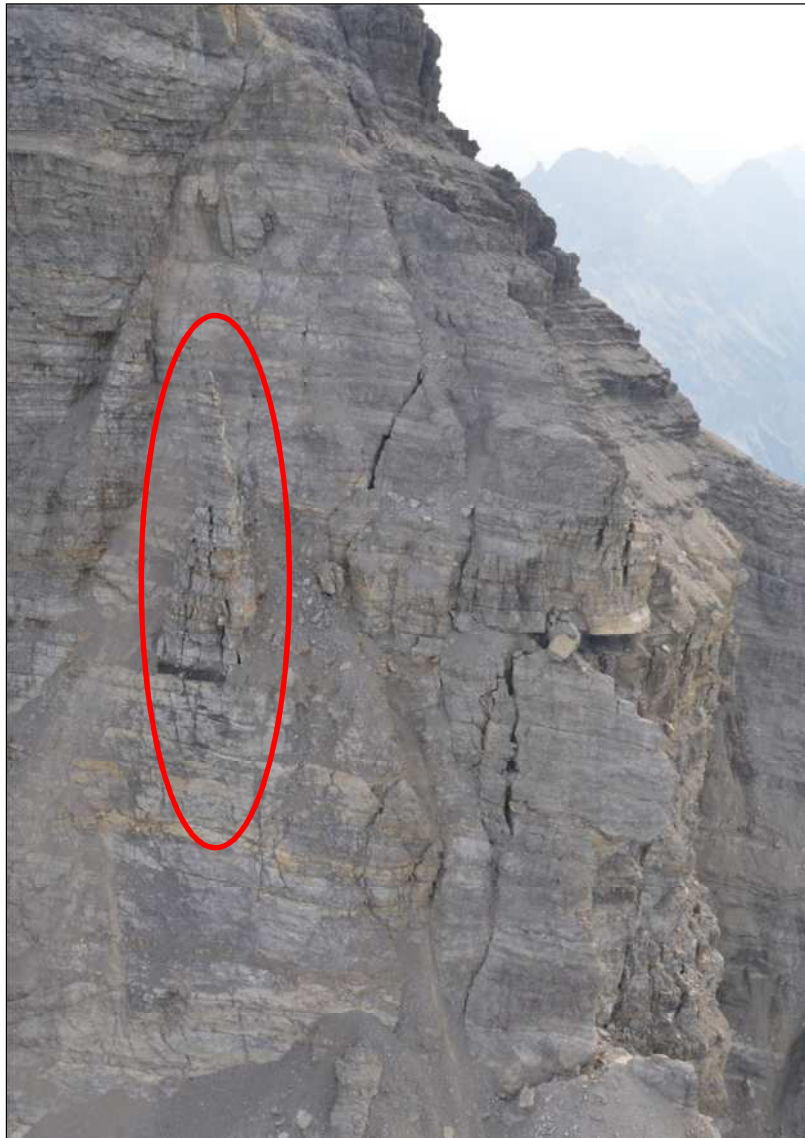
Foto 2: Ausschnitt aus der Ostwand. Mit roter Ellipse umrandet der im Befund genannte Felsturm. Rechts davon deutlich erkennbar die Zerlegung bzw. frische Spaltenbildung und dadurch bedingte Bildung von Felstürmen samt Vorbereitung des Absturzes teils ausgedehnter Wandpartien.
