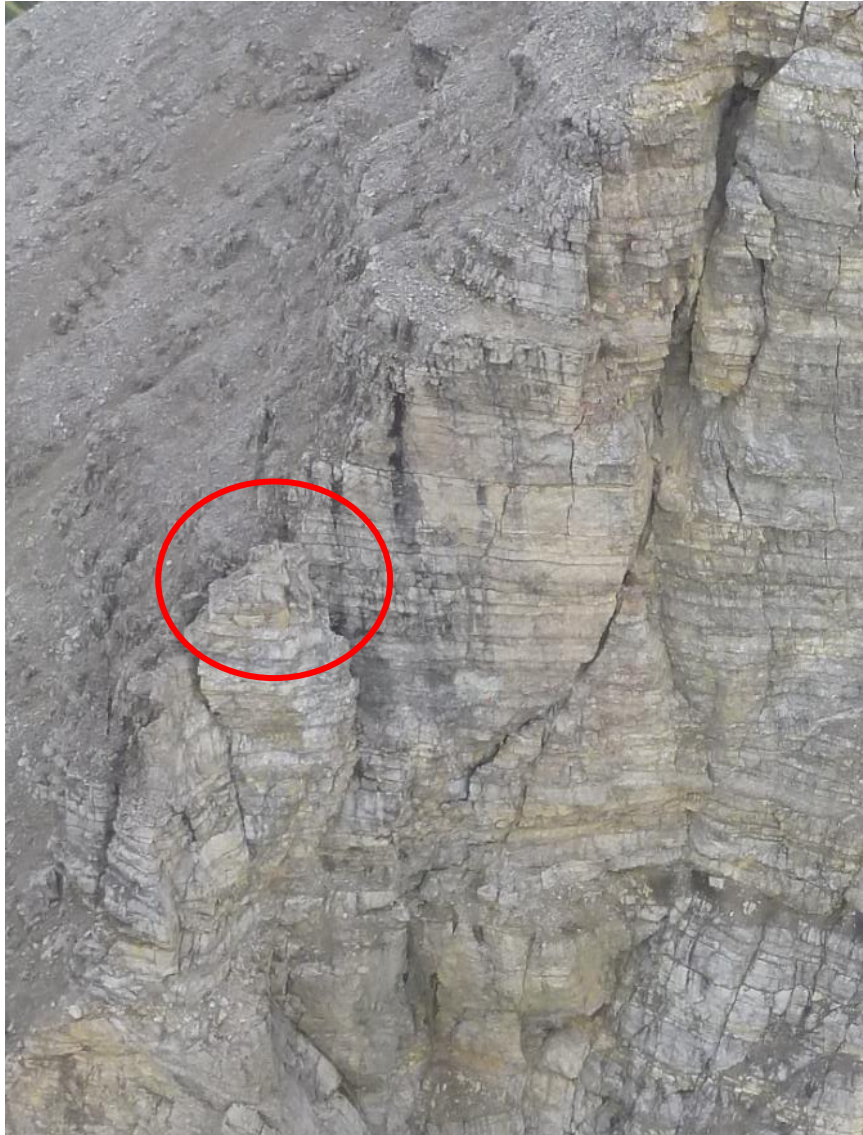
Foto 2: Am Westgrat löst sich bereits seit mehreren Jahren ein großer Felsturm vom dahinterliegenden Festgestein. Im obersten Bereich (rote Ellipse) waren gegenüber der letzten Befliegung im Jahr 2020 deutliche Massenverluste erkennbar.
