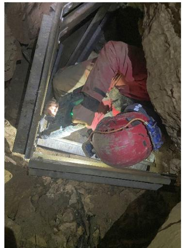
gegraben. Der nachrutschende Schutt wird professionell mit einem massiven Stahlkäfig gegen Einsturz gesichert. Mit einer ausgeklügelten Seilwindenkonstruktion werden zudem Erde und Dreck aus der Grabungsstelle befördert und somit können an einem Wochenende mehrere Zentimeter Tiefe gewonnen werden. Das erste Donau-Rieser Großhöhlensystem erscheint zum Greifen nahe ...
